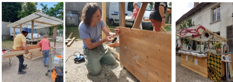
Les chantiers bricolage pour le festival : fabrication de la buvette
