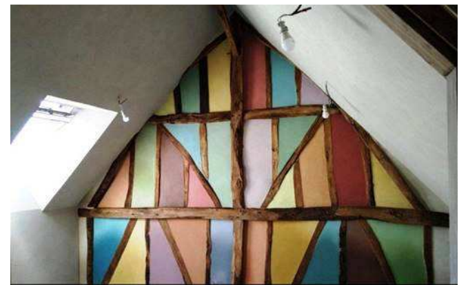
Enduit terre blanc sur rampants - enduit terre et pigments sur torchis
