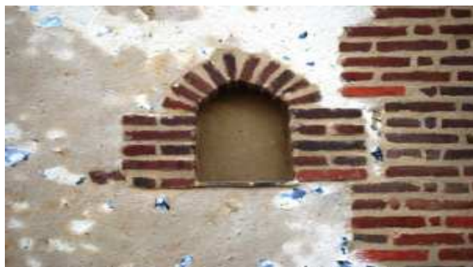
Enduit terre blanc sur rampants - enduit terre et pigments sur torchis
